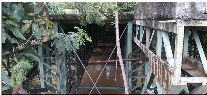
LOCAL ONDE SERÁ CONSTRUÍDA A ESCADA DE ACESSO À PONTE
