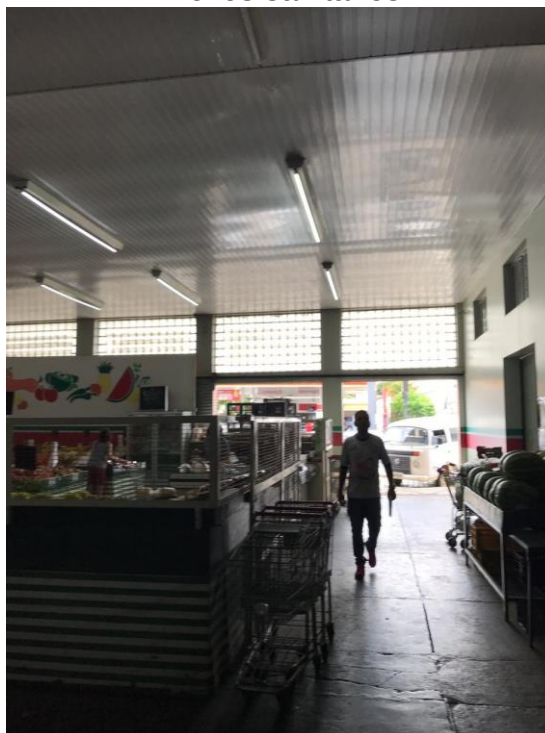
Foto 26 – Entrada Rua Ana Cintra – pavimento e forro a demolir.
