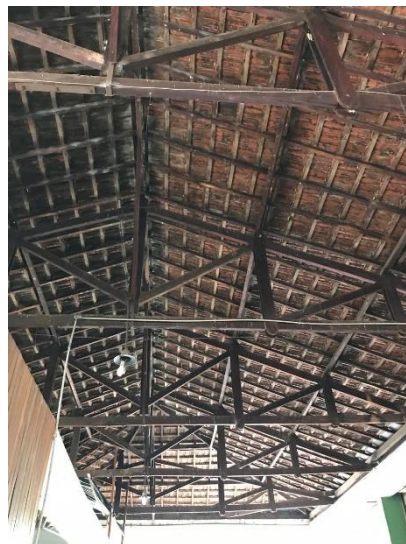
Foto 22 – Estrutura de madeira em tesouras.
