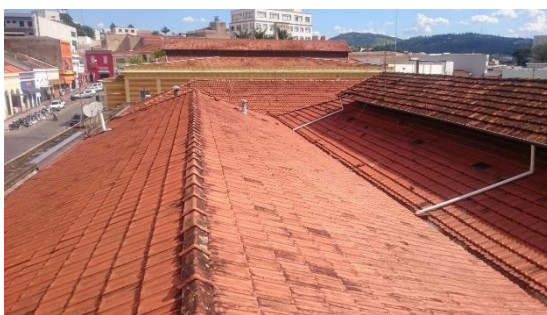
Foto 19 – Telhas cerâmicas tipo francesa sobre estrutura em tesouras
