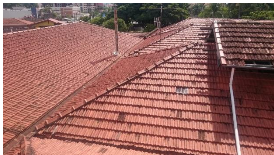
Foto 18 – Telhas cerâmicas tipo francesa sobre estrutura em tesouras.
