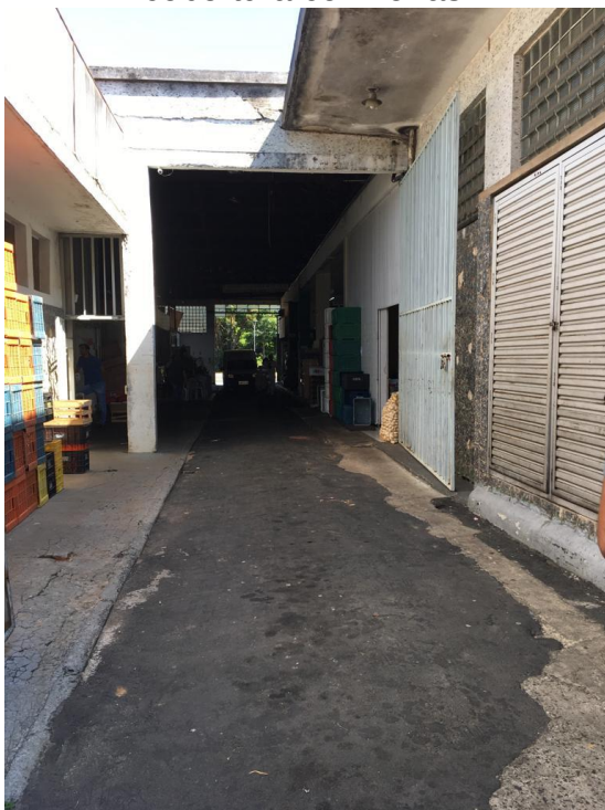
Foto 25 – Entrada Rua. Pref. Alcides – pavimento asfáltico a demolir.
