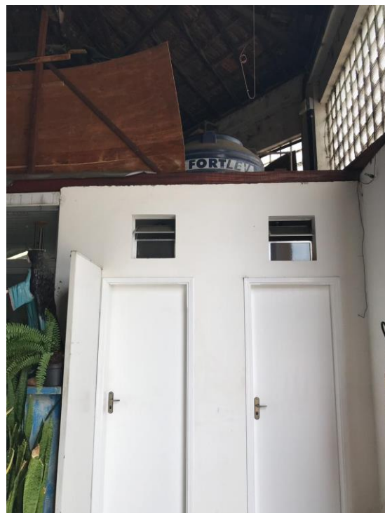
Foto 28 – Sanitários existentes a demolir.
