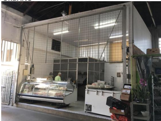
Foto 31 – Açougue a ser realocado – futuras instalações da floricultura.
