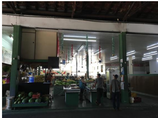
Foto 32 – Início da área de forro em PVC.
