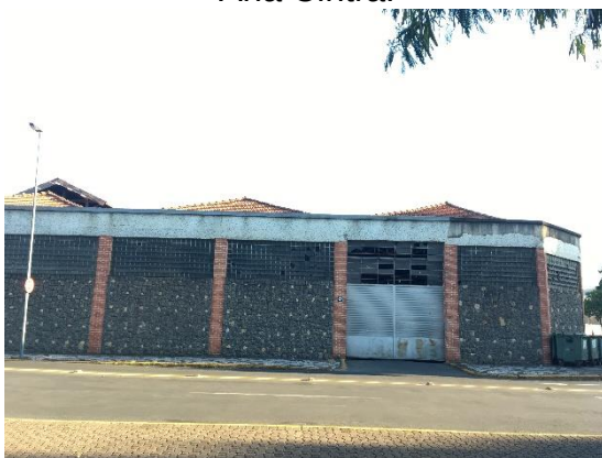
Foto 15 – Prédio principal – Av. Raul de Oliveira Fagundes
