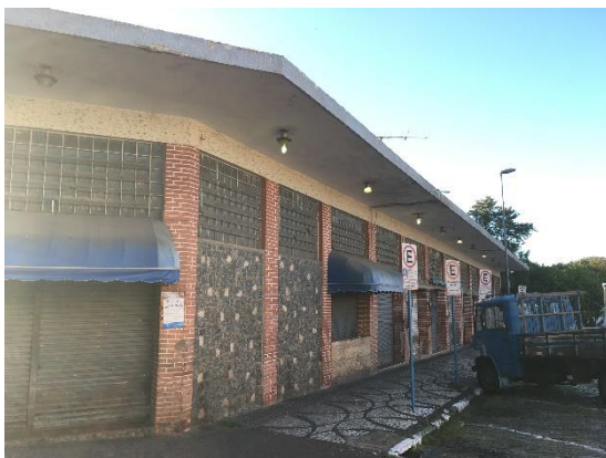
Foto 11 – Prédio principal – Rua. Ana Cintra.
