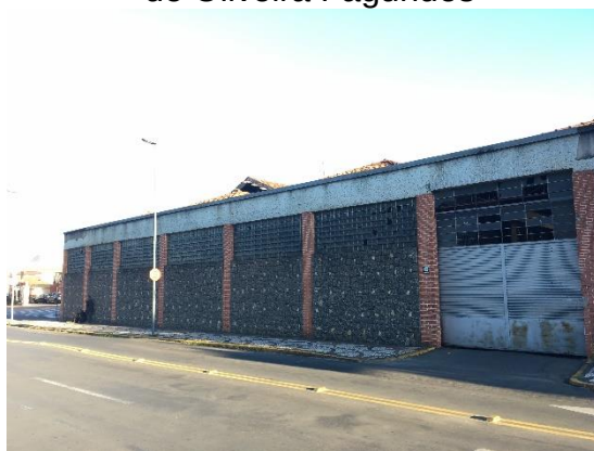
Foto 16 – Prédio principal – Av. Raul de Oliveira Fagundes
