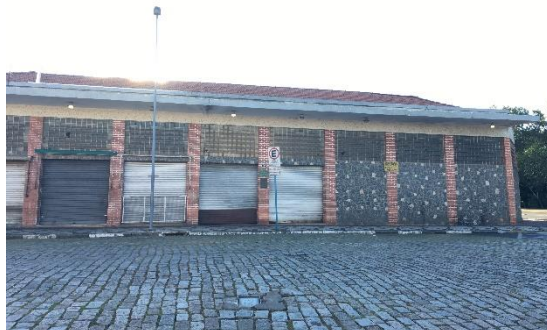
Foto 12 – Prédio principal – Rua. Ana Cintra.
