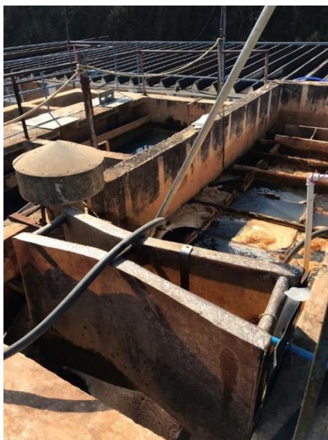
Figura 3. Calha Parshall (sistema de mistura rápida).
