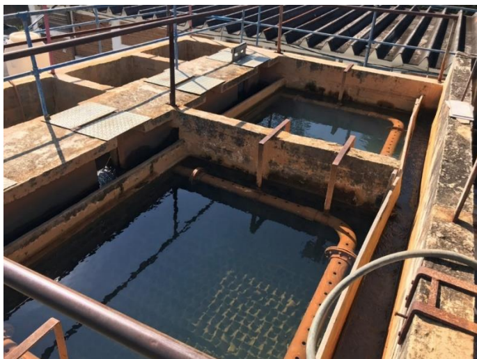
Figura 6. Sistema de decantação
