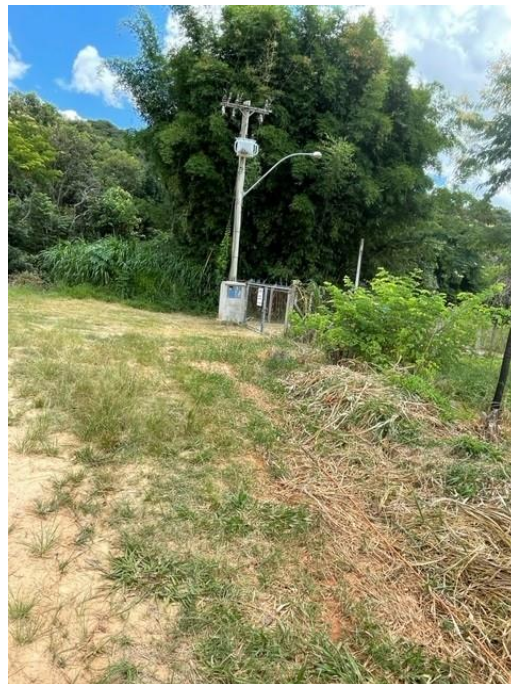
Foto 22. Vista da área do poço existente desativado ao longo do perfil AMP_19.
