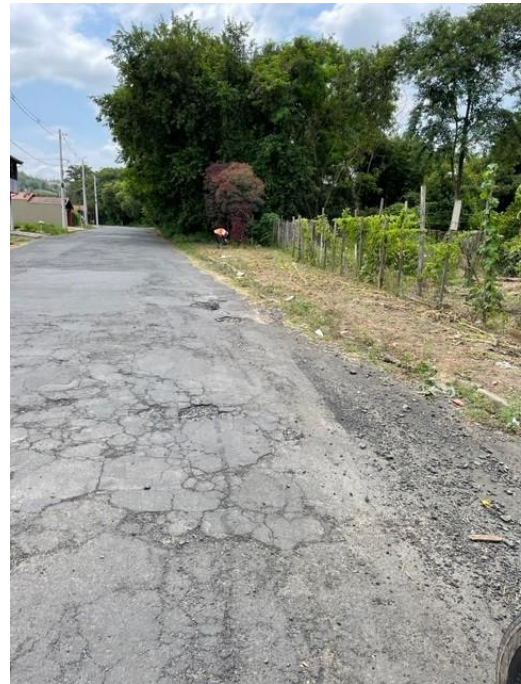
Foto 20. Montagem do perfil AMP_17 para início da leitura.
