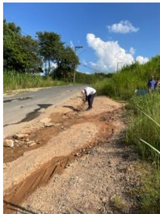
Foto 16. Perfil AMP_14, paralelo à drenagem, em frente uma nascente, no bairro Flamboyant.
