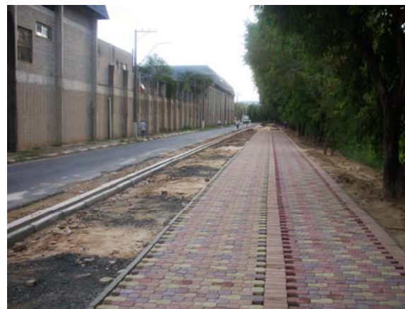
Obra de implantação da ciclovía do Parque Linear na Av. Francisco Prestes Maia.
